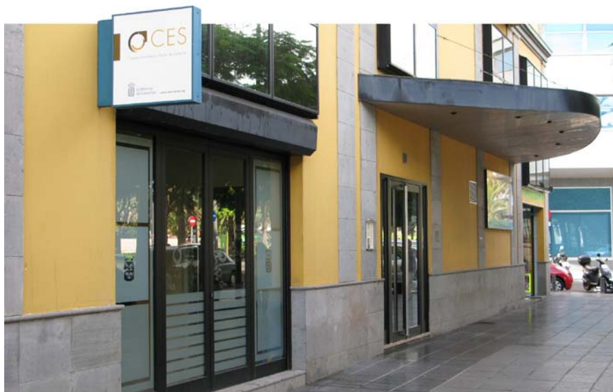
Fachada del edificio de la sede del CES de Canarias.
